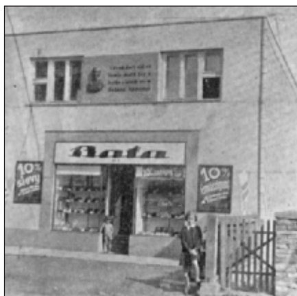
Obchodní dům Baťa ve Vsetíně.
