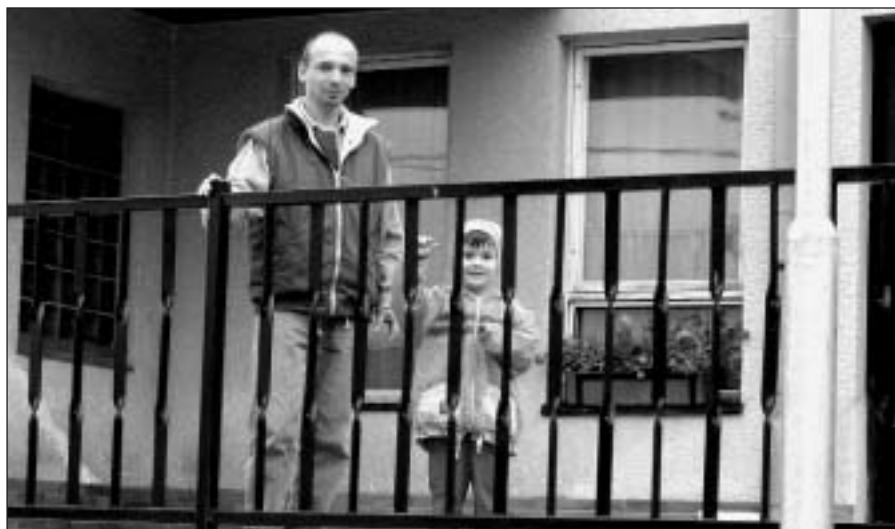
Bezpečné zábradlí a nový vstup do zahořanského obecního úřadu. (sh)
